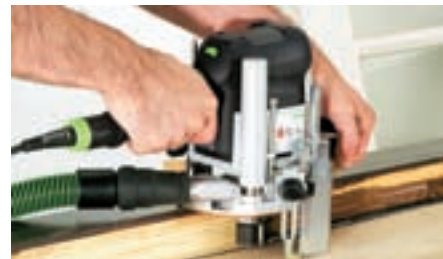
Pozostałości kleju i uszczelnienia mogą zostać prawie całkowicie usunięte przed wstawieniem szyb izolacyjnych.
